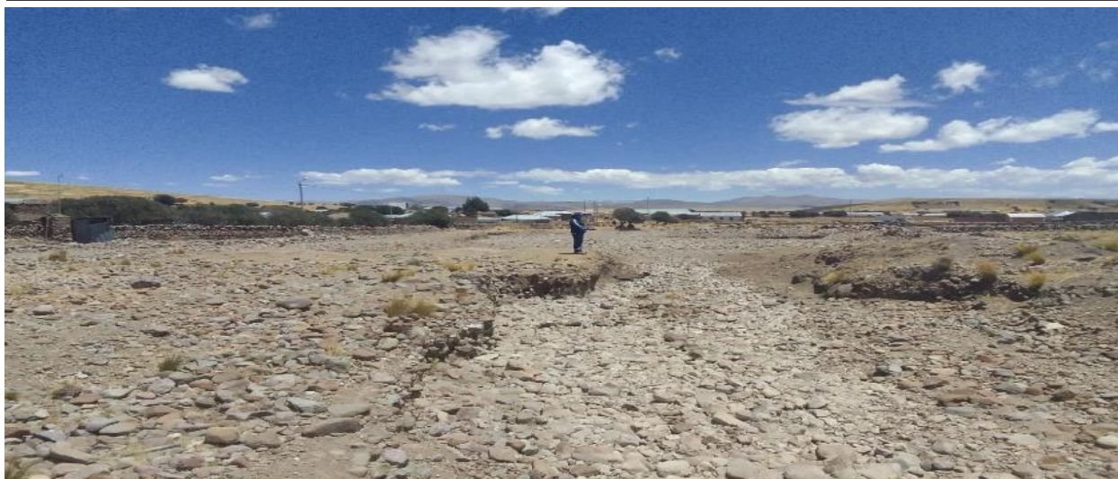
FIGURA N°02: EN LA TEMPORADA DE MAXIMAS AVENIDAS, DEL RIO HUANCARANI, SE APRECIA SOCAVACION DE DIQUE AFECTANDO A VIAS DE COMUNICACION
